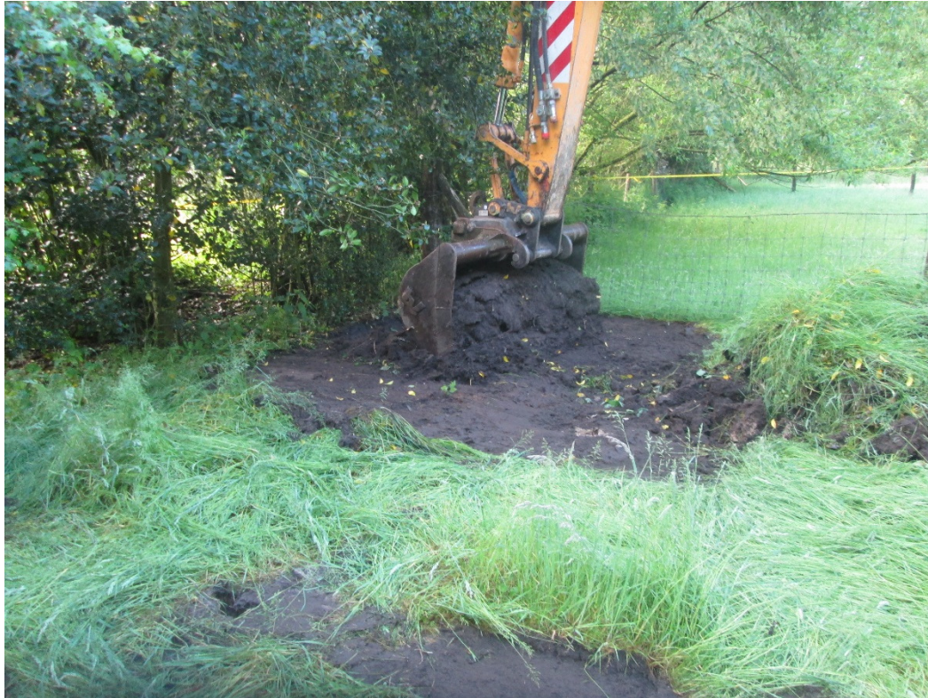
Aanvang ontgraving sterk verontreinigde grond
