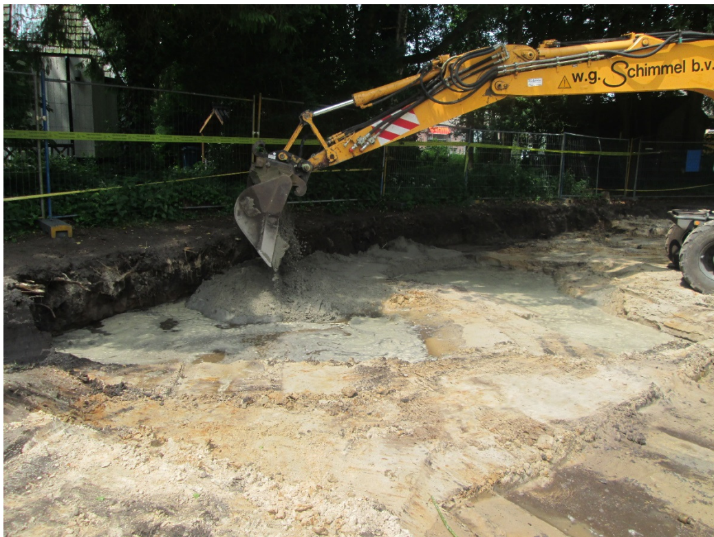
Aanvullen voormalig stortgaten met aanvulzand
