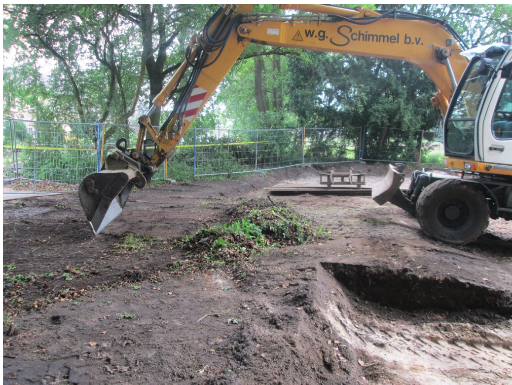
Voorzichtig graven onder bomen en tussen de boomwortels i.v.m. beschadigingen
