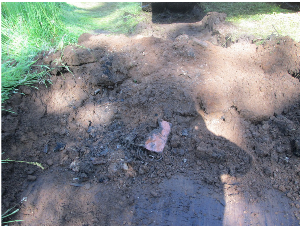
Bijmenging in de te ontgraven grond
