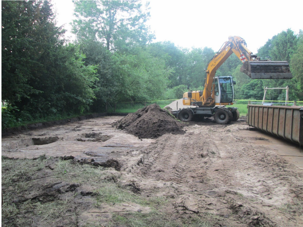
Verdere ontgraving na uitkeuren putbodems 01 en 02 en putwanden 01 t/m 06 en analyse uitslagen die voldoen volgens saneringsplan
