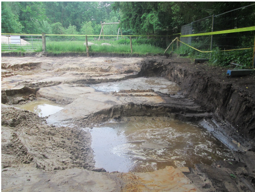
Na ontgraving met stijgend grondwater
