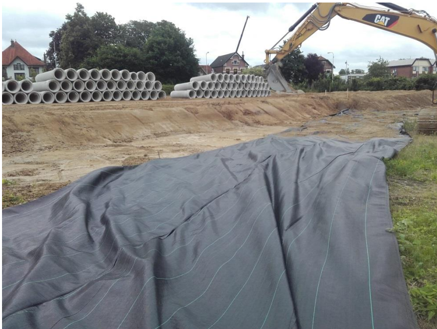
F10, aanbrengen signaallaag bij te maken parkeerplaatsen
