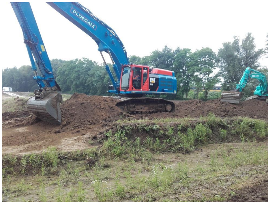
F3, ontgaven en verwerken voor ophoging
