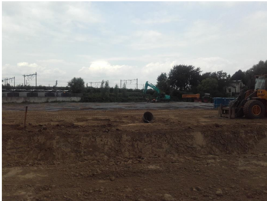
F11, aanbrengen signaallaag bij te maken parkeerplaatsen
