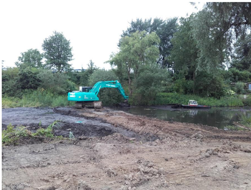
F14, overzetten bagger naar nog niet gebaggerd deel vijver
