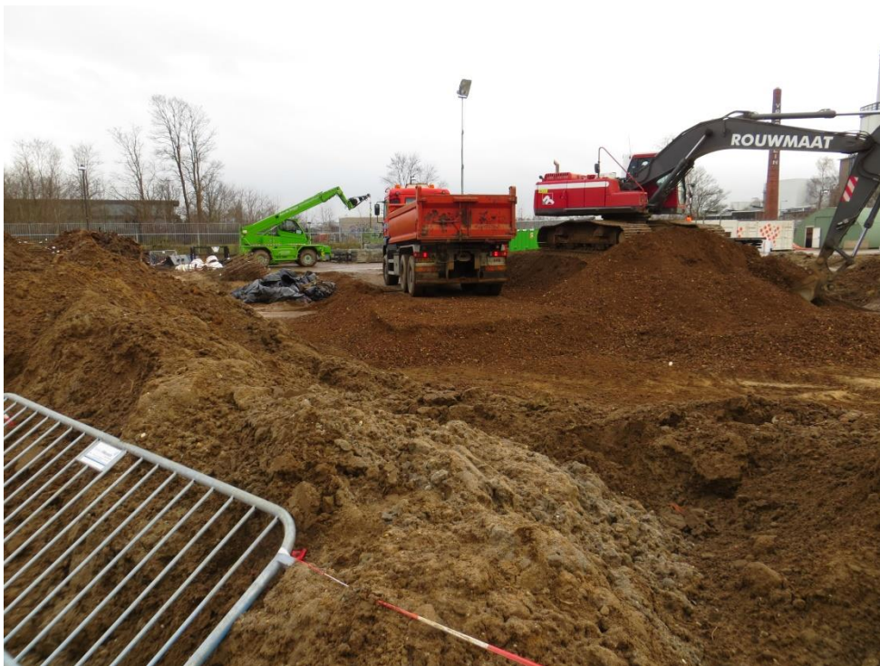
foto 32: IMG_7575.JPG: Laden t.b.v. transport van het depot gebroken puin die binnen het werkterrein gelegen was.
