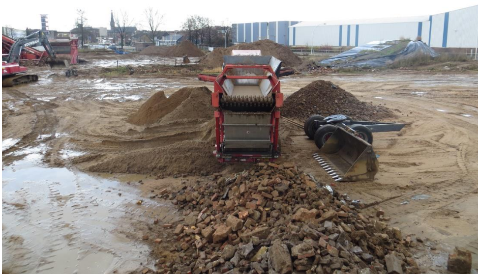
foto 22: IMG_6912.JPG: Overzichtsfoto's vanaf het grofpuindepot tijdens uitvoering ontgraven, zeven en herschikken uitgezeefde grond.
