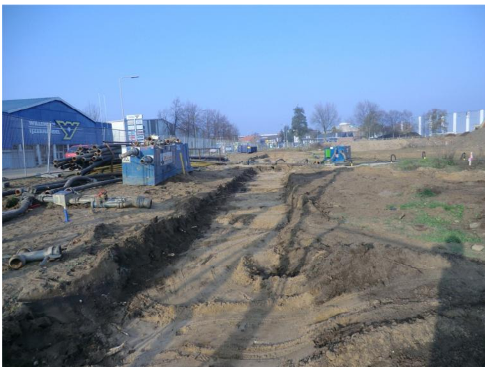
Foto 27: Eindsituatie kabel en leidingstrook langs C. Missetstraat (westzijde). De bovengrond met bijmenging is in depot geplaatst op het middenterrein.
