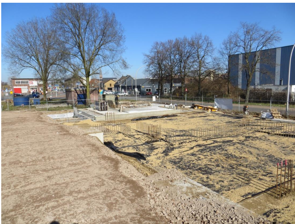
foto 19: IMG_7898.JPG Idem foto 17. Ter plaatse van de inpandige parkeerplaats is het eerder als tijdelijk afdeklaag gebruikte (aangevoerde) menggranulaat als funderingslaag aangebracht, na herschikken van de verontreinigde grond in deze beschikbare herschikruimte.
