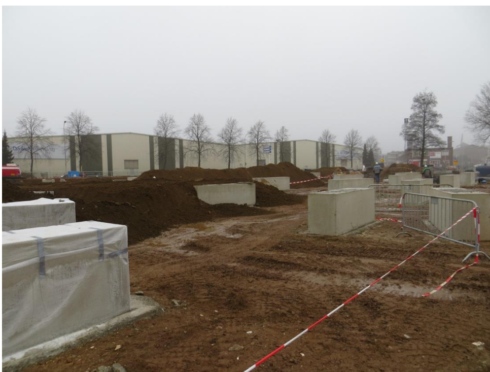
foto 14: IMG_7493.JPG: Herschikken verontreinigde grond tussen de funderingsblokken.
