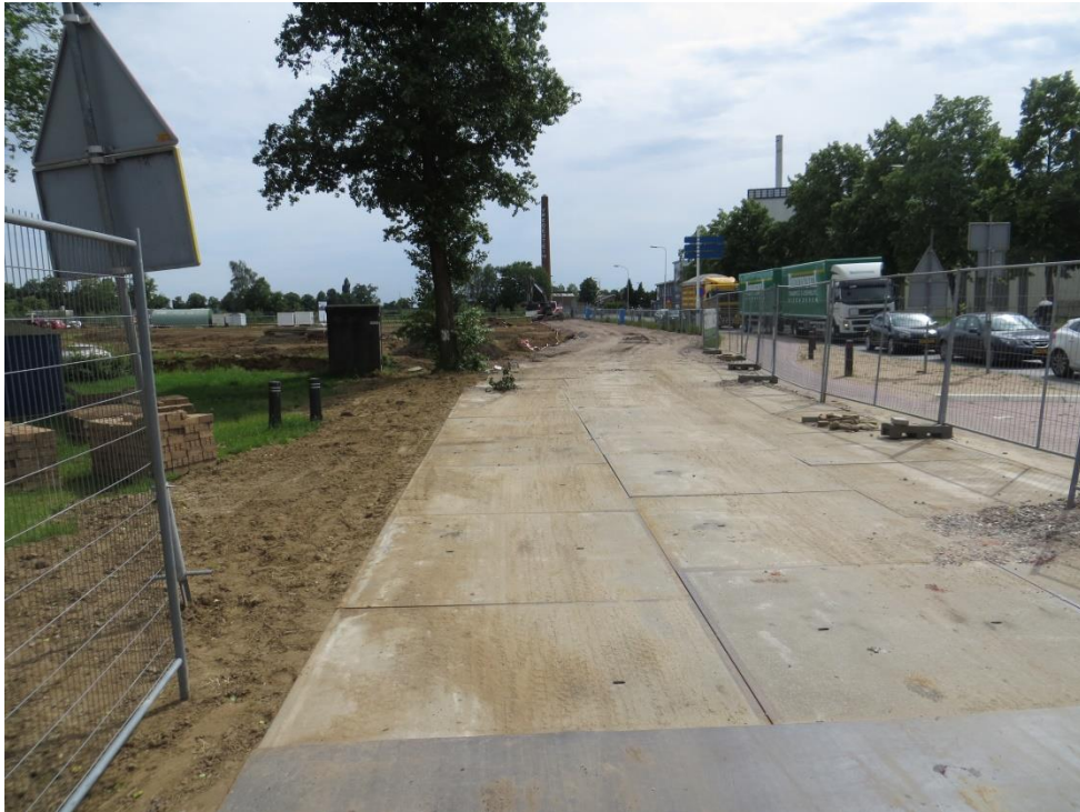
foto 11: IMG_4399.JPG: Op het terrein ten noorden van de saneringslocatie is met prefab betonplaten een bouwweg aangelegd .....
