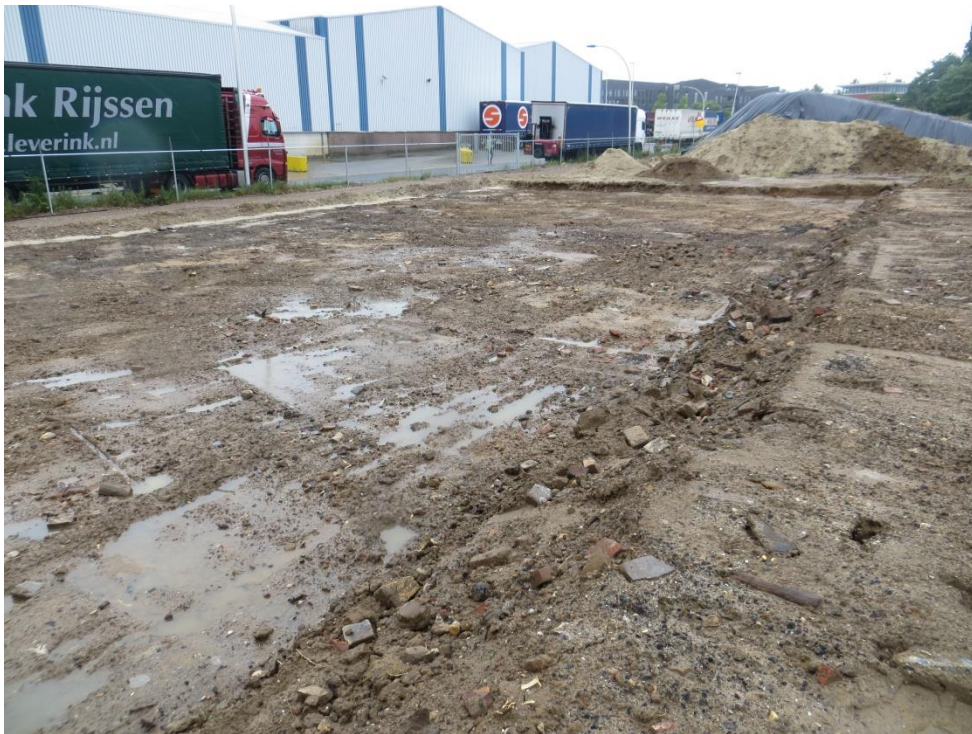
foto 19: IMG_4467.JPG: foto 28 mei 2014: Bij ontgraving (noordoosthoek toekomstig pand) tot onderkant toekomstige vloeren/fundatiestroken werd dusdanig veel en grof puin aangetroffen dat problemen verwacht werden met het plaatsen van boorpalen.
