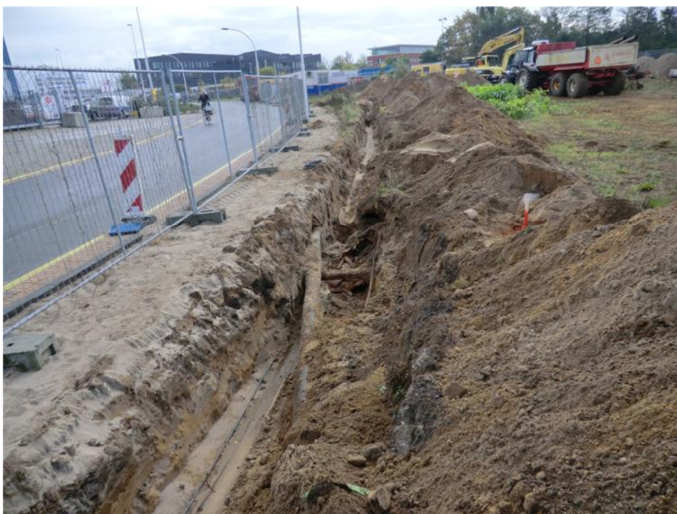
Foto 3: Start werkzaamheden, opzoeken bestaande kabels en leidingen langs Stationsstraat (oostzijde). Verontreinigde grond in depot langs sleuf.
