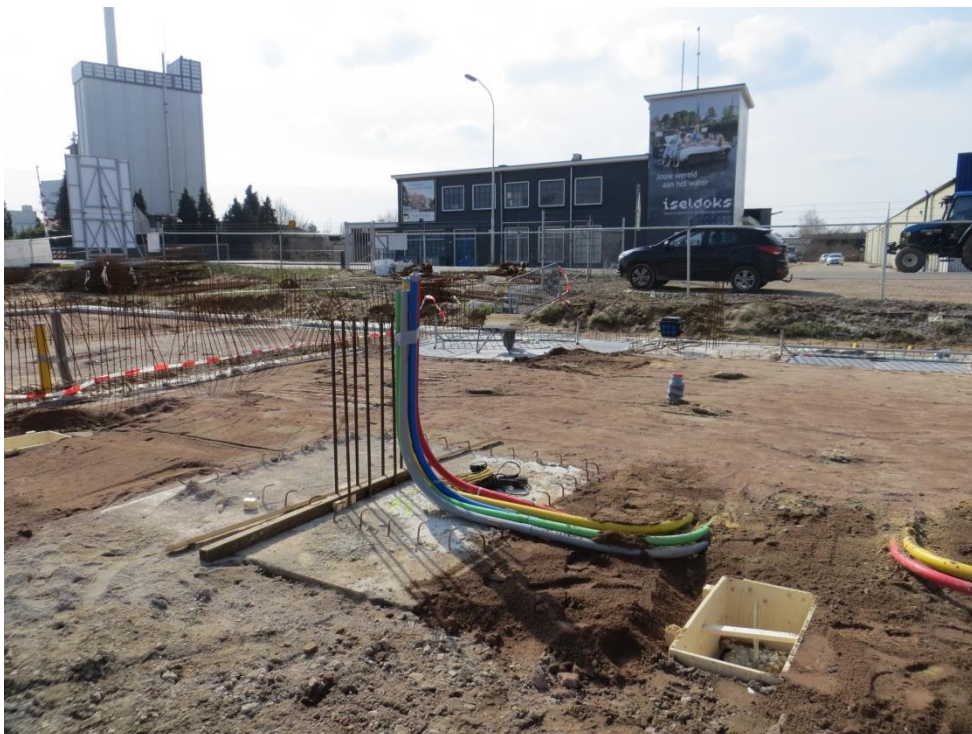
foto 22: IMG_8101.JPG: Ook in de zuidwesthoek van de nieuwbouw is men (bijna) zover dat de vloeren aangelegd kunnen worden op de tussen de funderingen herschikte grond.
