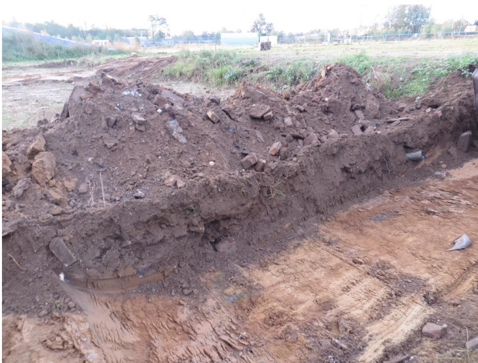
foto 3: IMG_6499.JPG: Proefsleuf oktober 2014 n.a.v. bodemscan. O.a. grof puin aangetroffen.
