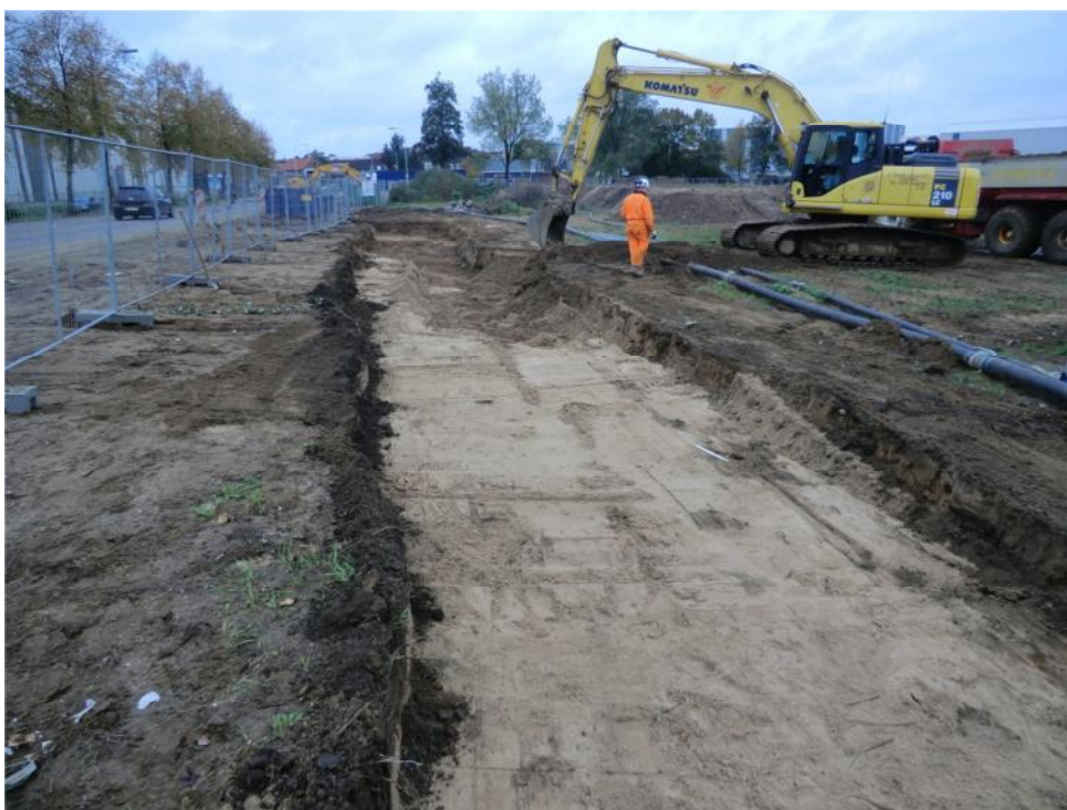
Foto 9: Eindsituatie kabel en leidingstrook langs C. Missetstraat (westzijde). De bovengrond met bijmenging is in depot geplaatst op het middenterrein.
