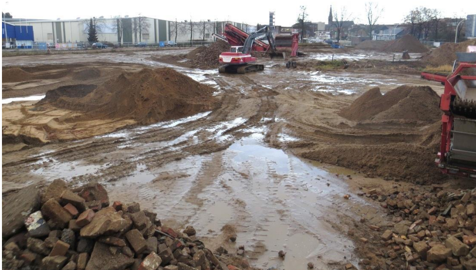
foto 21: IMG_6911.JPG: Overzichtsfoto's vanaf het grofpuindepot tijdens uitvoering ontgraven, zeven en herschikken uitgezeefde grond.
