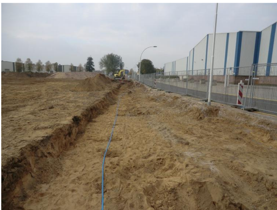
Foto 6: Overzicht eindsituatie ontgraving kabel en leidingsleuf (incl. groenstrook) langs Stationsstraat (oostzijde).
