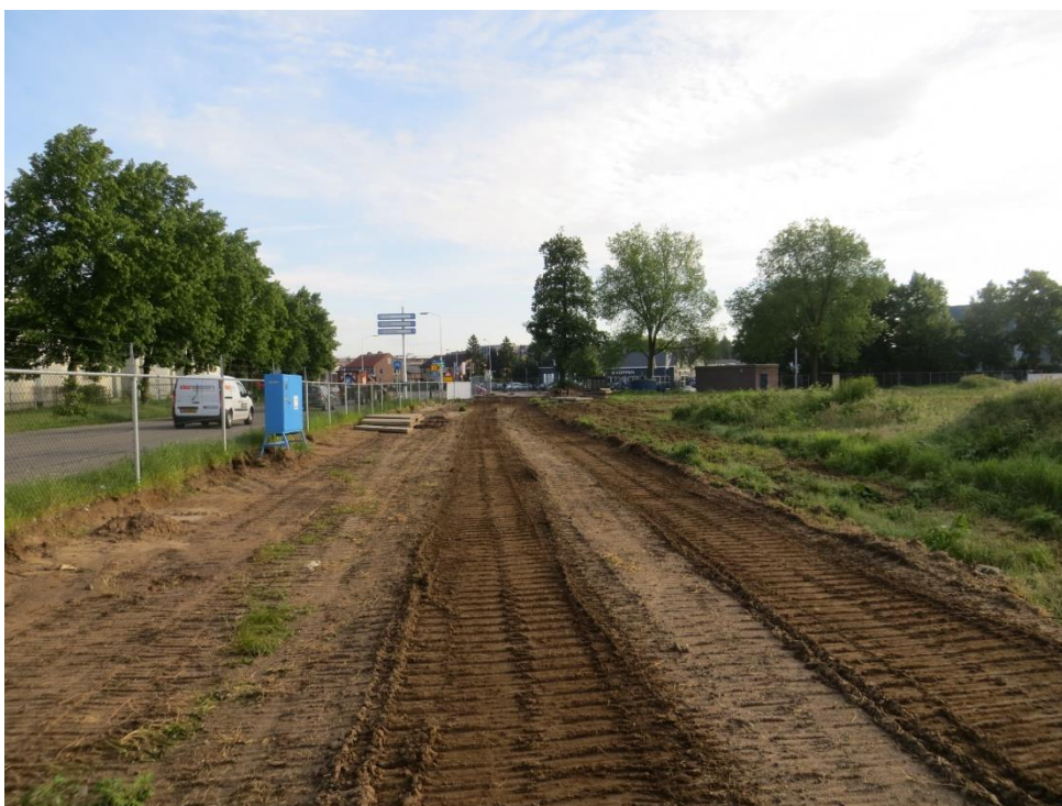
foto 5: IMG_4140.JPG: Voor aanleg van de bouwweg aan de westzijde (zijde C. Missetstraat) is beperkt ontgraven/geëgaliseerd. Alhier bleken geen bijmengingen waaraan het voorkomen van de verontreiniging is gerelateerd aanwezig.
