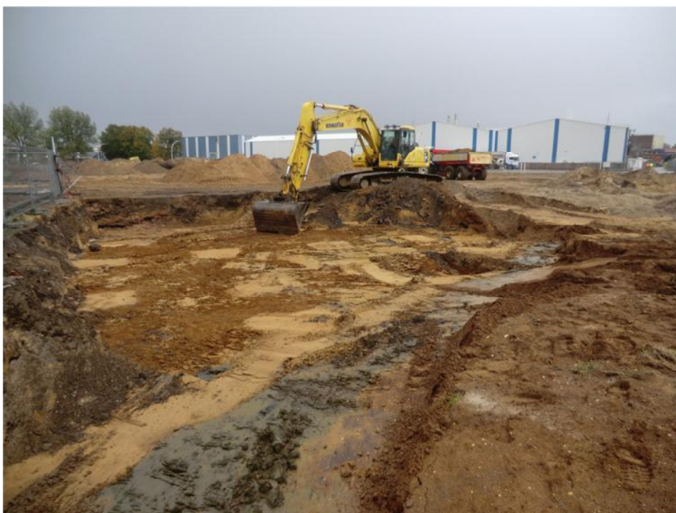
Foto 13: Ontgraving in uitvoering, einde verontreinigde laag duidelijk herkenbaar.
