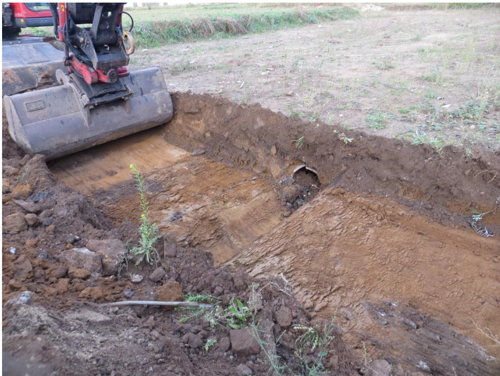
foto 2: IMG_6497.JPG: Proefsleuf oktober 2014 n.a.v. bodemscan. Lijnvormige verstoring op bodemscan bleek een riool (gresbuizen).
