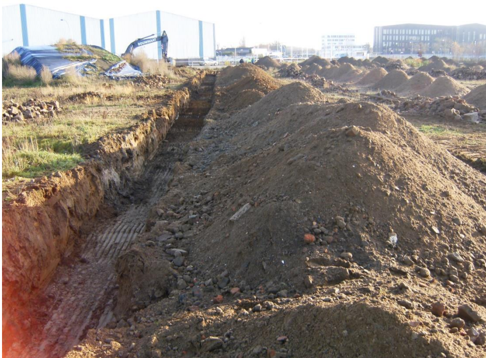
foto 8: HPIM5915.JPG: Proefsleuven december 2014 (n.a.v. bodemscan en proefsleuven oktober 2014). Gegraven en 'uitgezeefd' met zeef-/puinbak aan de graafmachine voor indicatie hoeveelheid grof puin.
