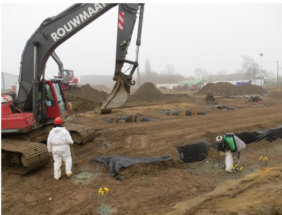
foto 12: IMG_7472.JPG: Uitgegraven fundatiesleuven oostzijde nieuwbouw.
