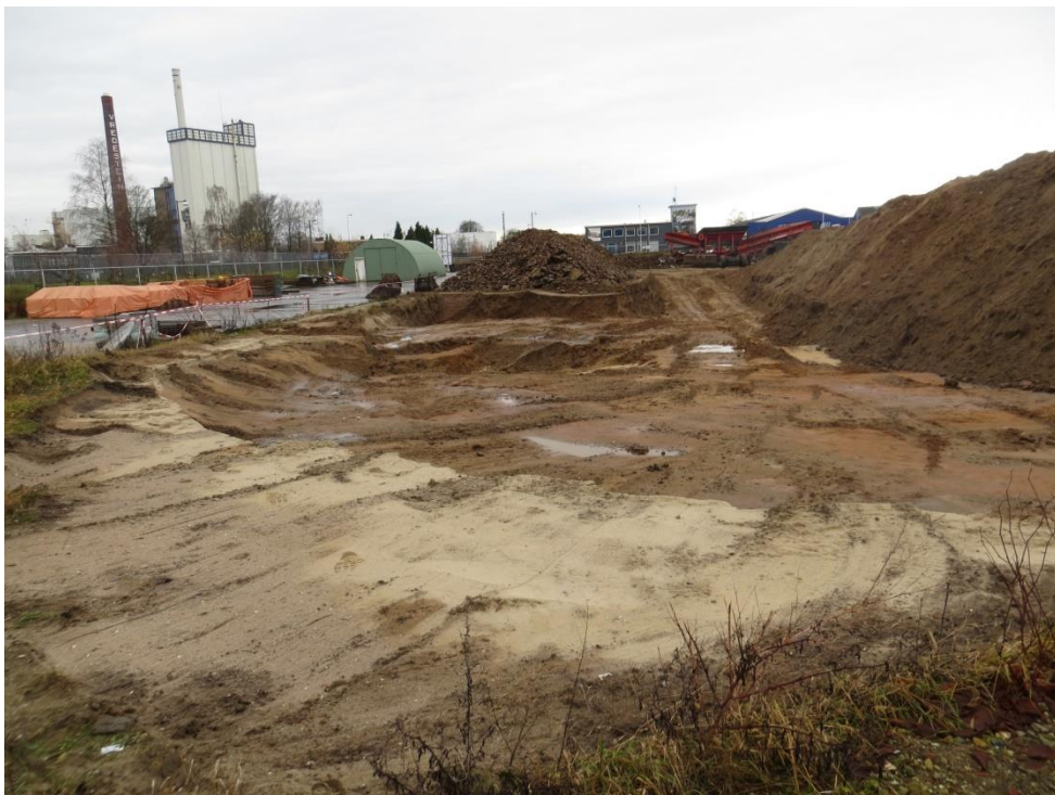
foto 14: IMG_6850.JPG: In de zuidoosthoek is het aanvulzand zichtbaar van de van de in 2011 gesaneerde K&L-sleuf en parkeervakken / aanleg riool.
