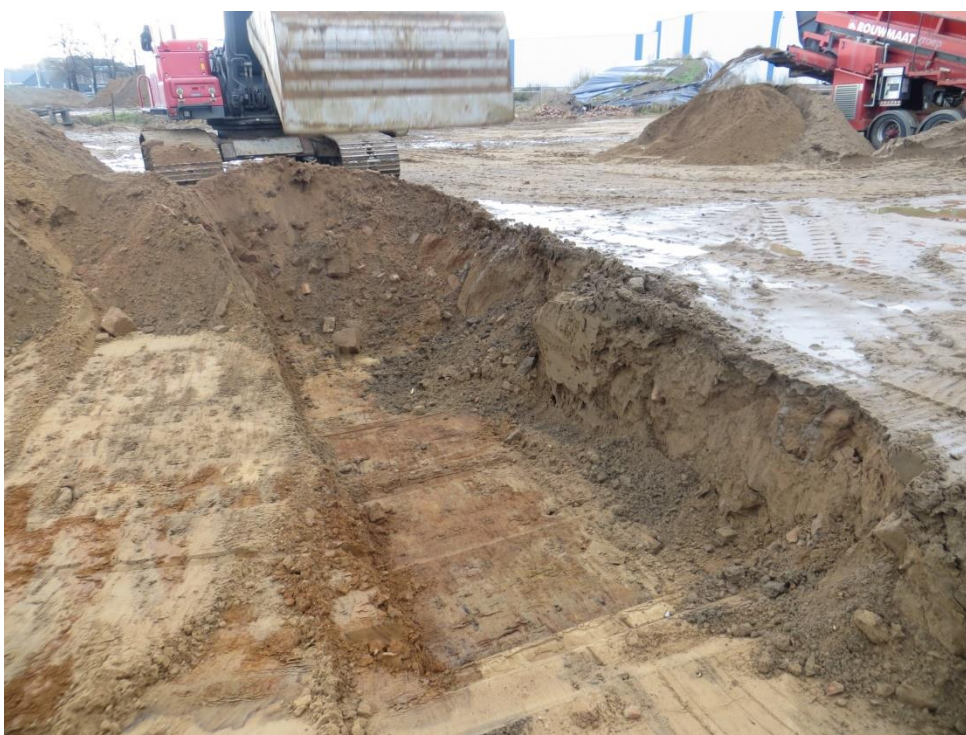
foto 19: IMG_6908.JPG: Ontgraving in verticale richting beperkt tot de laag met bijmengingen, welke visueel goed waarneembaar was.
