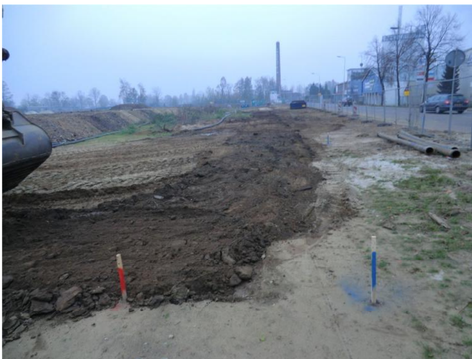
Foto 23: eindresultaat ontgraving kabel en leidingsleuf langs C. Missetstraat (noorwestzijde). Tijdens de graafwerkzaamheden zijn geen bijmengingen aangetroffen welke gerelateerd zijn aan de verontreinigingssituatie. De ontgraven grond is teruggeplaatst.
