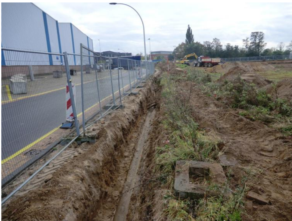
Foto 2: Start werkzaamheden, opzoeken bestaande kabels en leidingen langs Stationsstraat (oostzijde)
