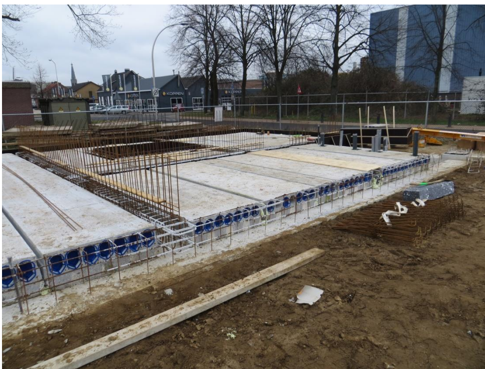
foto 17: IMG_7854.JPG: Voor aanbrengen van de vloeren van de nieuwbouw, is tussen de fundaties de verontreinigde grond herschikt en afgedekt met folie.
