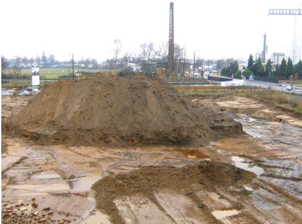
foto 10: HPIM5940.JPG: Ontgraving in verticale richting beperkt tot de laag met bijmengingen.
