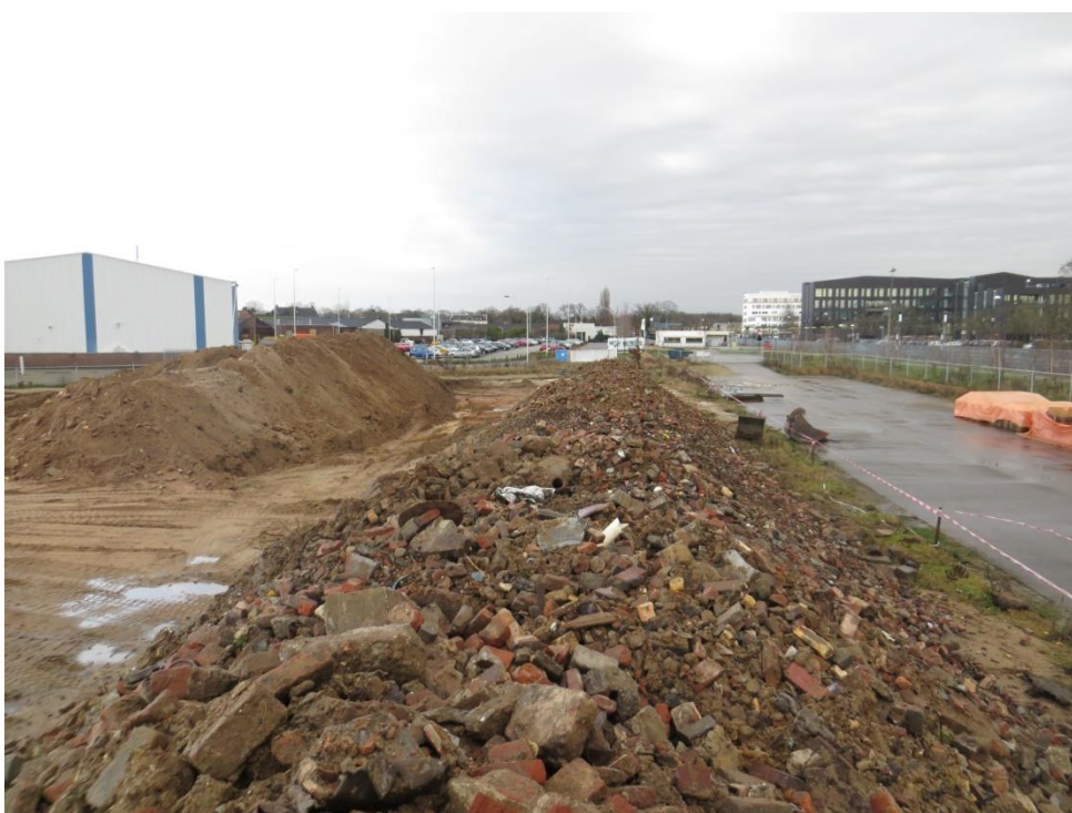
foto 24: IMG_6914.JPG: Overzichtsfoto's vanaf het grofpuindepot tijdens uitvoering ontgraven, zeven en herschikken uitgezeefde grond.
