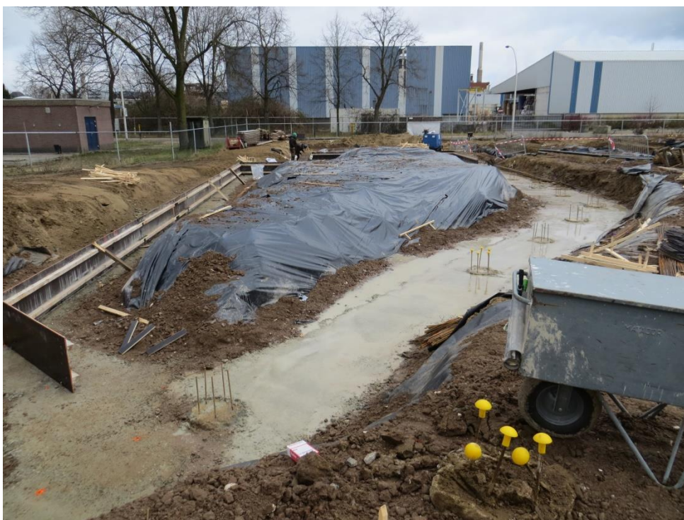
foto 10: IMG_7353.JPG: 1 e beton gestort (werkvloertje) in fundatiesleuven noordoosthoek nieuwbouw. Verontreinigde grond afgedekt met folie en werkvloertje, zodat bouwvakkers niet met verontreinigde grond in aanraking komen.
