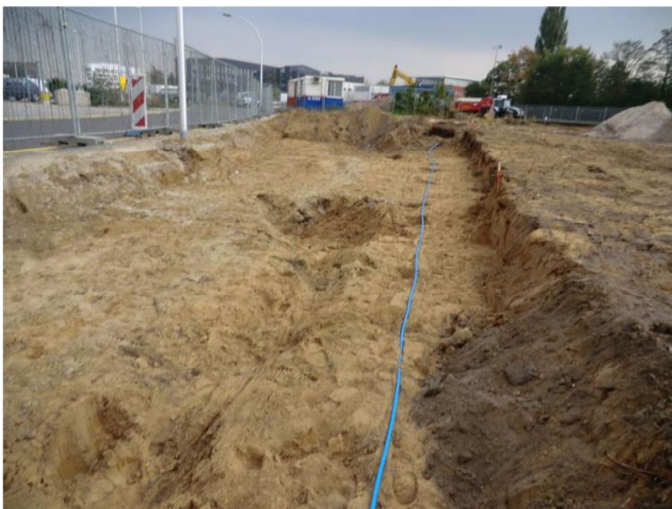
Foto 5: Overzicht eindsituatie ontgraving kabel en leidingsleuf (incl. groenstrook) langs Stationsstraat (oostzijde).
