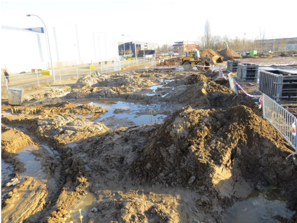
foto 8: IMG_7292.JPG: Drie fasen werk in uitvoering op met lint afgebakende verschillende terreindelen, nl.: Links: plaatsing boorpalen (idem foto 1); Rechts: bekisting voor storten beton fundaties; en Achtergrond: werkzaamheden herschikken uitgezeefde grond.
