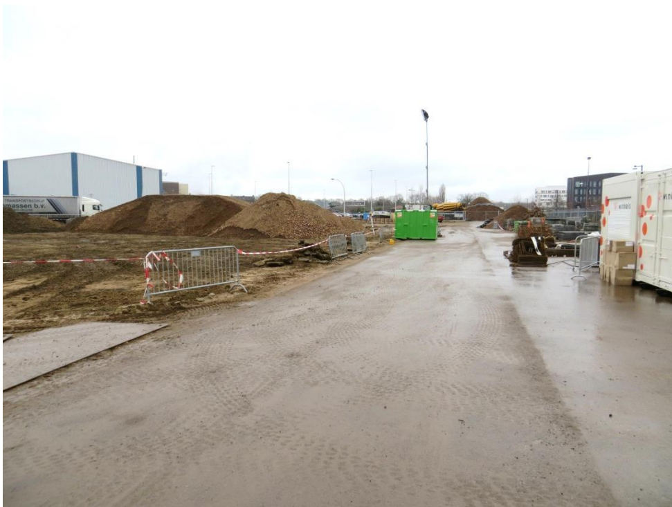
foto 31: IMG_7344.JPG: Gebroken puin opgeslagen in drietal depots: één op het werkterrein (net links van de groene container) en twee rechts op de achtergrond nog net zichtbaar buiten het werkterrein op geasfalteerde parkeerterreinen. Het depot uiterst links op de achtergrond betreft uitgezeefde (nog te herschikken) grond.
