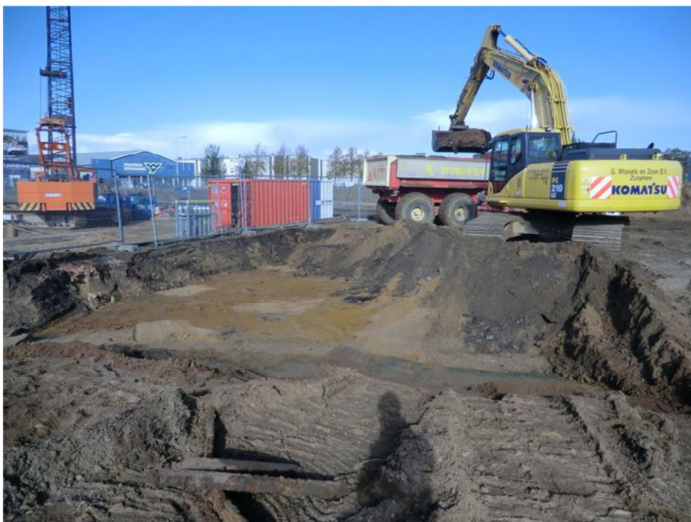
Foto 12: Ontgraving in uitvoering, einde verontreinigde laag duidelijk herkenbaar.
