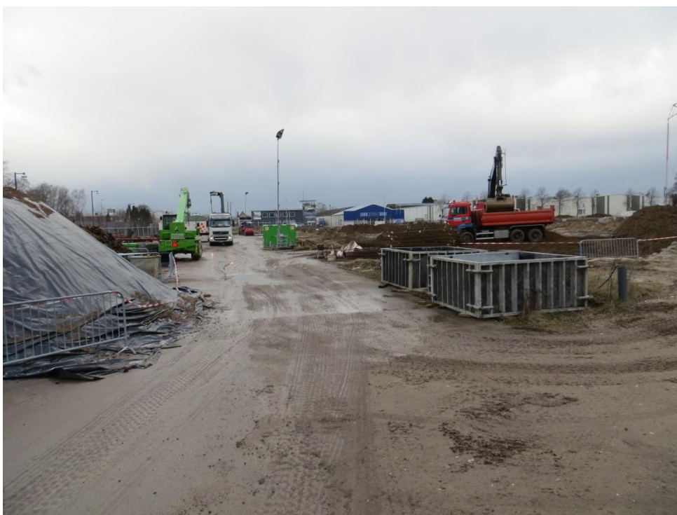
foto 15: IMG_7573.JPG: Rechts laden t.b.v. transport van het depot gebroken puin - zoals vrijgekomen bij de zeefwerkzaamheden - die binnen het werkterrein gelegen was.
