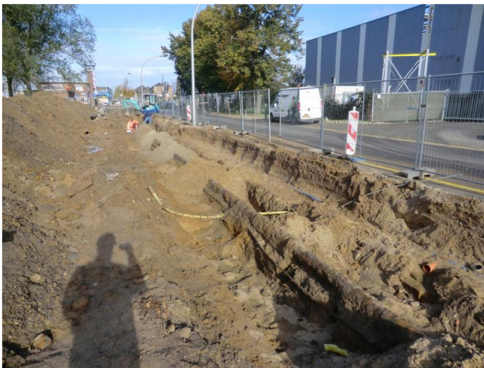
Foto 14: Overzicht eindsituatie ontgraving kabel en leidingsleuf (incl. groenstrook) langs Stationsstraat (oostzijde). De sleuf is reeds gedeeltelijk aangevuld met schoon zand om de bestaande gasleiding te stabiliseren.
