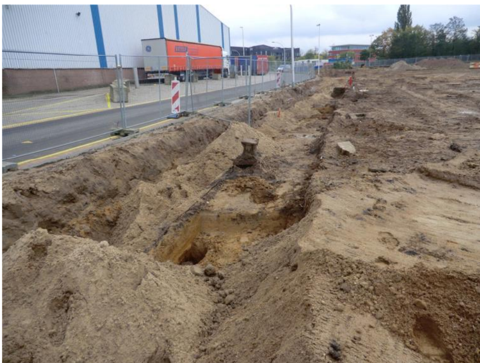
Foto 11: Overzicht eindsituatie ontgraving kabel en leidingsleuf (incl. groenstrook) langs Stationsstraat (oostzijde). De sleuf is reeds gedeeltelijk aangevuld met schoon zand om de bestaande gasleiding te stabiliseren.
