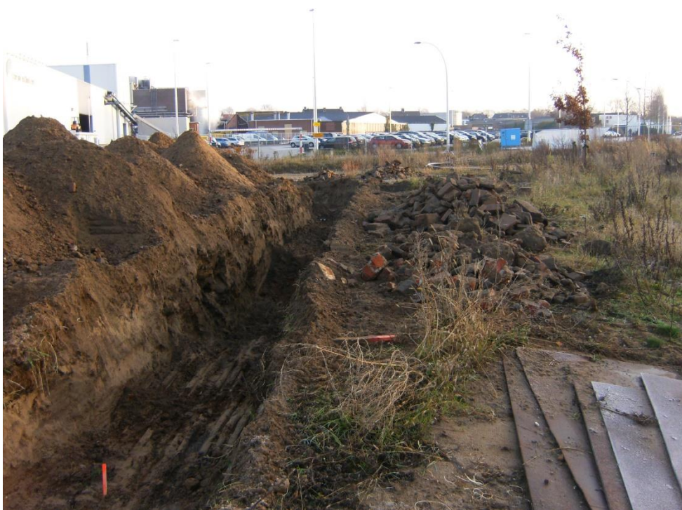
foto 6: HPIM5888.JPG: Proefsleuven december 2014 (n.a.v. bodemscan en proefsleuven oktober 2014). Gegraven en 'uitgezeefd' met zeef-/puinbak aan de graafmachine voor indicatie hoeveelheid grof puin.
