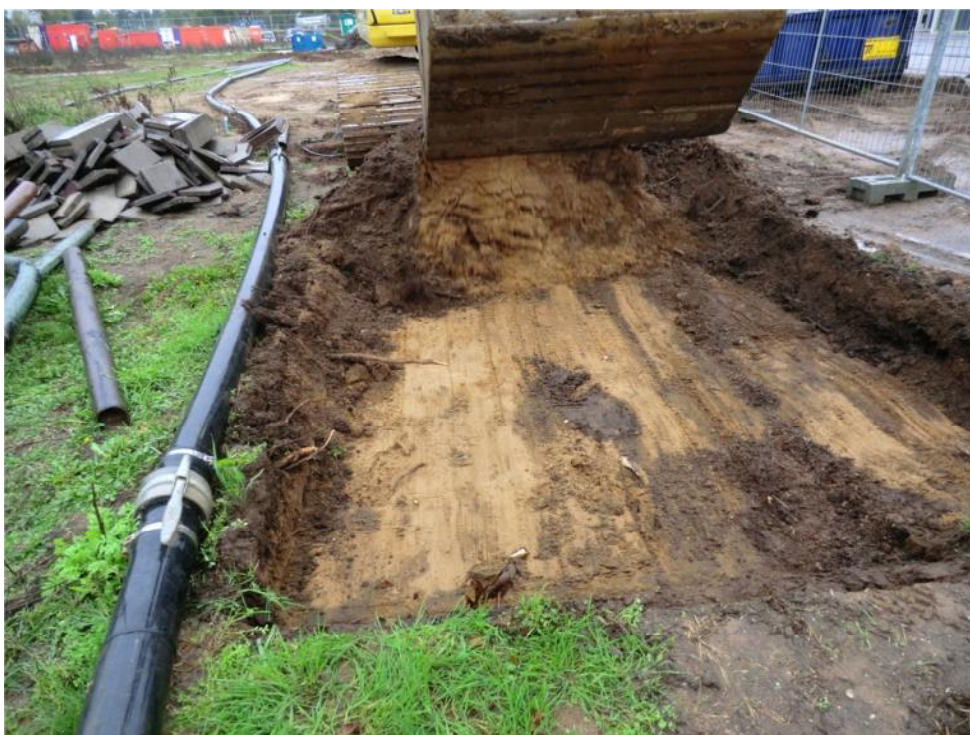
Foto 7: Ontgraving in uitvoering. Kabel en leidingstrook langs C. Missetstraat (westzijde). Tijdens de graafwerkzaamheden zijn geen bijmengingen waargenomen. De grond is ontgraven en teruggeplaatst.
