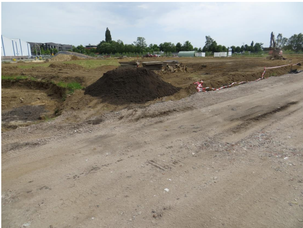
foto 14: IMG_4401.JPG: De beoogde groenstrook op het noordelijk deel van de saneringslocatie is ontgraven tot 1 m minus toekomstig maaiveldniveau.
