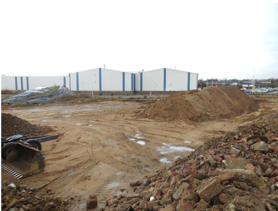
foto 23: IMG_6913.JPG: Overzichtsfoto's vanaf het grofpuindepot tijdens uitvoering ontgraven, zeven en herschikken uitgezeefde grond.
