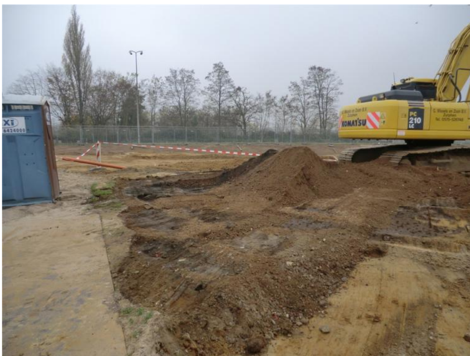
Foto 21: ontgraving in uitvoering van de groenstrook en overhoogte aan de zuidoostzijde langs de Stationsstraat.
