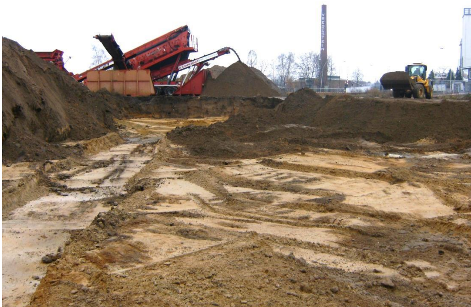
foto 12: HPIM5953.JPG: Zeefinstallatie en herschikken uitgezeefde grond in actie.
