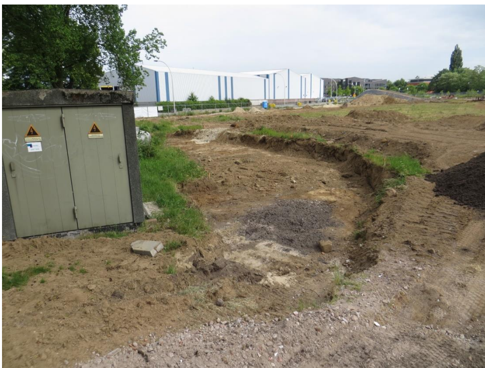
foto 15: IMG_4402.JPG: In de putbodem worden nog diverse bijmengingen aangetroffen (restverontreiniging).
