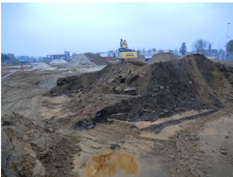
Foto 22: ontgraving in uitvoering van de groenstrook en overhoogte aan de zuidoostzijde langs de Stationsstraat. Einddiepte verontreinigde laag duidelijk herkenbaar.
