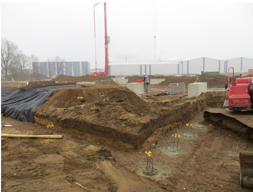
foto 13: IMG_7473.JPG: Uitgegraven fundatiesleuven westzijde nieuwbouw. Vrijgekomen grond opgeslagen op de beschikbare herschikruimte.
