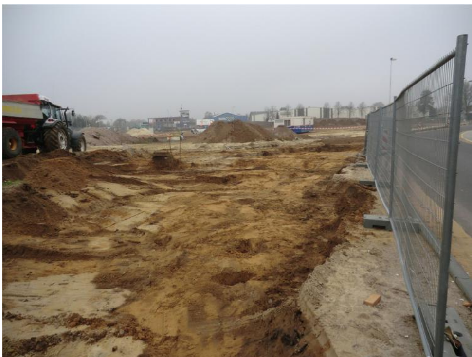
Foto 19: ontgraving in uitvoering van de groenstrook en overhoogte aan de zuidoostzijde langs de Stationsstraat.
