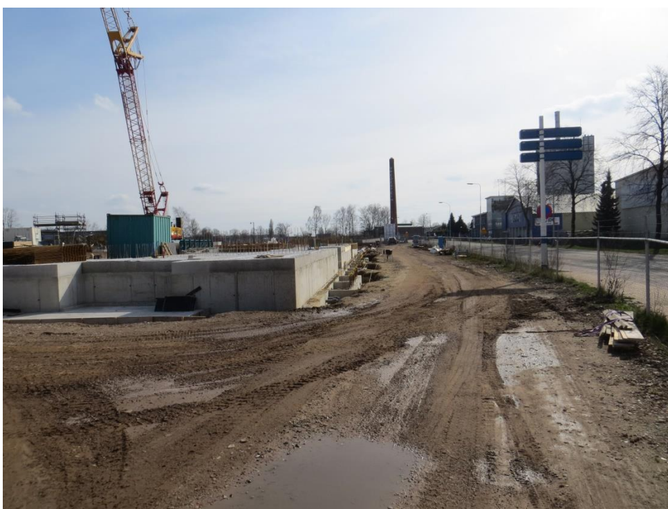
foto 20: IMG_8086.JPG: O.a het zogenoemde Blok 1 (zijde C. Missetstraat) kent een hoger aanlegpeil. De ruimtes tussen de aangelegde funderingen, onder de vloeren zijn dan ook gebruikt om de verontreinigde grond te herschikken. Kijkrichting: zuid.
