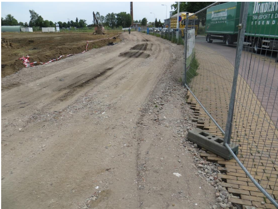
foto 12: IMG_4400.JPG: ..... welke op de saneringslocatie (westzijde / zijde C. Missetstraat) overgaat in een bouwweg aangelegd met aangevoerd menggranulaat.
