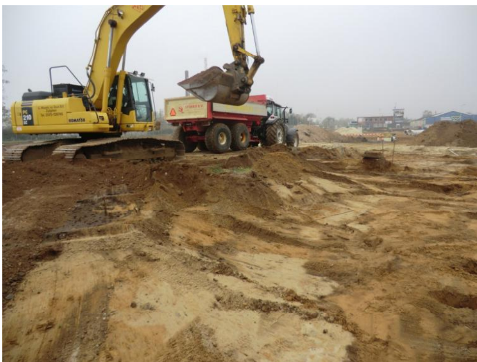
Foto 20: ontgraving in uitvoering van de groenstrook en overhoogte aan de zuidoostzijde langs de Stationsstraat.
