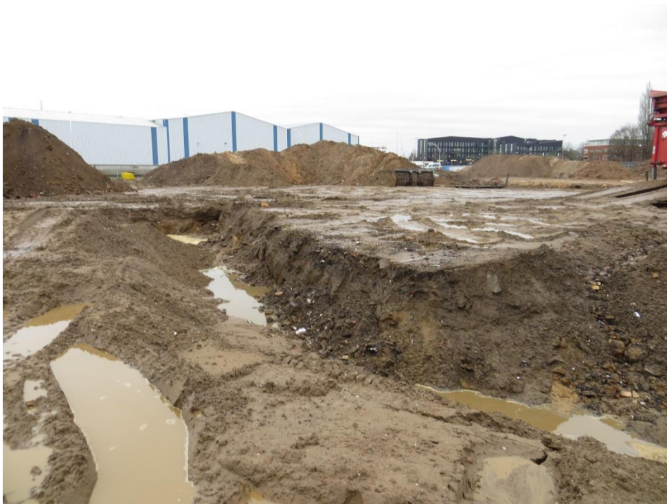
foto 18: IMG_6885.JPG: Links: uitgezeefde herschikte grond. Rechts: nog te ontgraven en te zeven grond.
