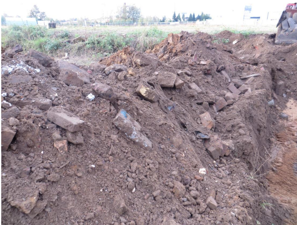
foto 4: IMG_6500.JPG: Proefsleuf oktober 2014 n.a.v. bodemscan. O.a. grof puin aangetroffen.
