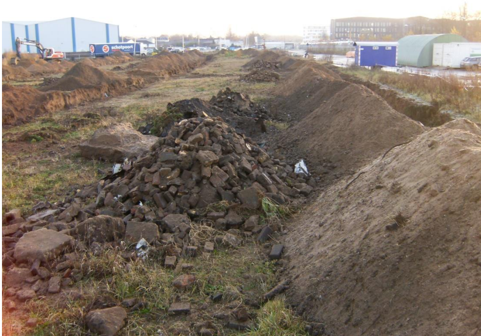
foto 5: HPIM5879.JPG: Proefsleuven december 2014 (n.a.v. bodemscan en proefsleuven oktober 2014). Gegraven en 'uitgezeefd' met zeef-/puinbak aan de graafmachine (nog net zichtbaar op achtergrond) voor indicatie hoeveelheid grof puin.
