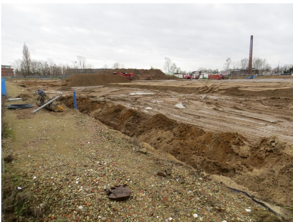
foto 26: IMG_7065.JPG: Overzichtsfoto's medio januari 2015, zeefwerk nadert zijn einde. Uitgezeefde grond grotendeels herschikt.
