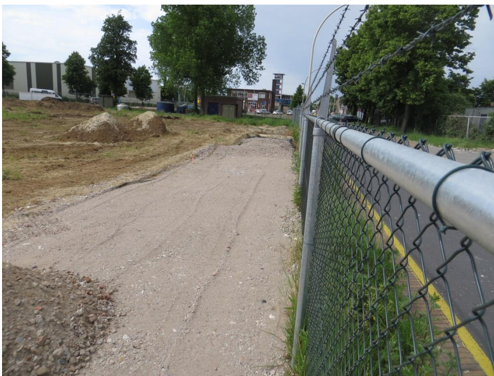
foto 9: IMG_4393.JPG: Bouwweg is aangelegd met aangevoerd menggranulaat.
