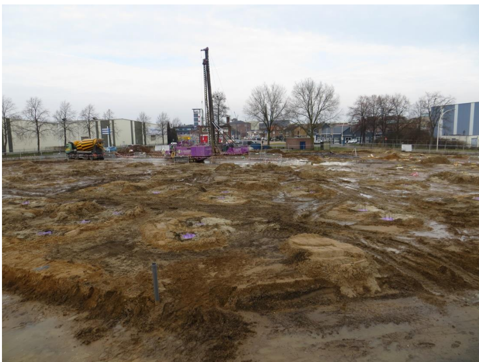
foto 1: IMG_7123.JPG: Plaatsing boorpalen. Vrijgekomen grond ter plaatse herschikt.
