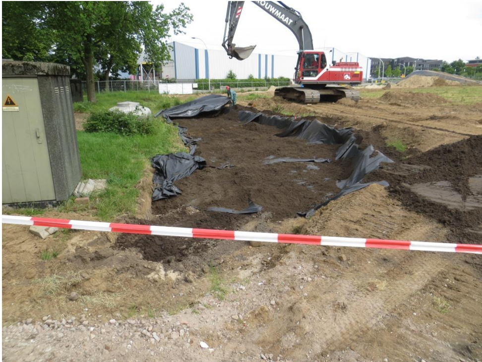
foto 17: IMG_4404.JPG: Na aanbrengen van een signaallaag (geotextiel) is deze toekomstige groenstrook deels aangevuld met teelaarde (en later afgedekt met menggranulaat om als tijdelijke verharding van de bouwplaats te dienen).
