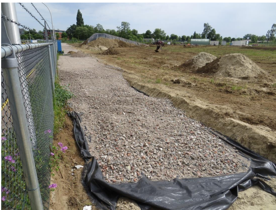
foto 10: IMG_4398.JPG: Voor aanbrengen van het menggranulaat is een geotextiel aangebracht. Hierbij kwam een beperkt deel van het in 2011 bij de realisatie van de K&L-sleuf aangebrachte zand vrij. Op de achtergrond een depot verontreinigde grond (met bijmengingen) afgedekt met folie, vrijgekomen uit ontgraving meer centraal op het terrein.
