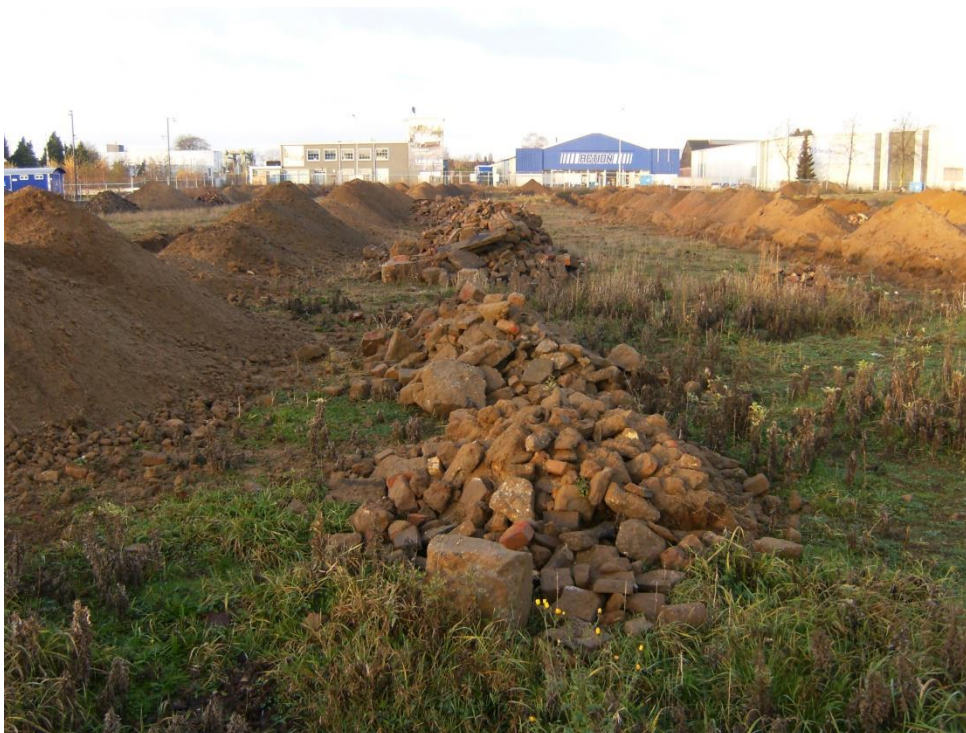
foto 7: HPIM5892.JPG: Proefsleuven december 2014 (n.a.v. bodemscan en proefsleuven oktober 2014). Gegraven en 'uitgezeefd' met zeef-/puinbak aan de graafmachine voor indicatie hoeveelheid grof puin.
