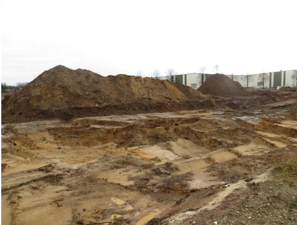
foto 15: IMG_6864.JPG: Ontgraving in verticale richting beperkt tot de laag met bijmengingen. Tussentijdse depots 'nog uit te zeven' en 'uitgezeefde' grond.
