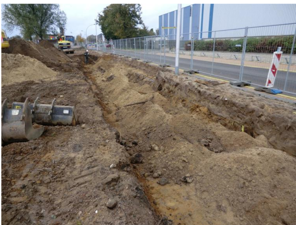
Foto 10: Overzicht eindsituatie ontgraving kabel en leidingsleuf (incl. groenstrook) langs Stationsstraat (oostzijde). De sleuf is reeds gedeeltelijk aangevuld met schoon zand om de bestaande gasleiding te stabiliseren.
