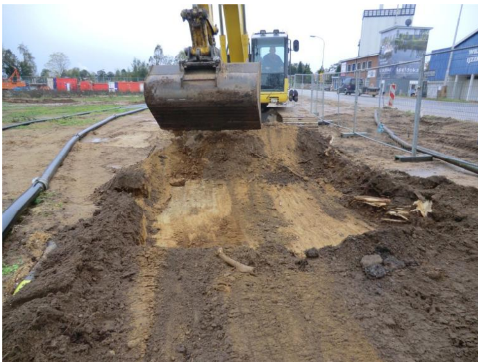
Foto 8: Ontgraving in uitvoering. Kabel en leidingstrook langs C. Missetstraat (westzijde). Tijdens de graafwerkzaamheden zijn geen bijmengingen waargenomen. De grond is ontgraven en teruggeplaatst.
