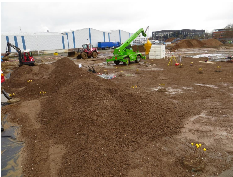
foto 5: IMG_7232.JPG: Ter voorkoming dat de bouwvakkers met verontreinigde grond in aanraking komen, is een \pm 10 cm dikke laag (aangevoerd) menggranulaat op een geotextiel toegepast. Dit menggranulaat is later als funderingslaag van de inpandige parkeerplaats gebruikt (zie foto 19).
