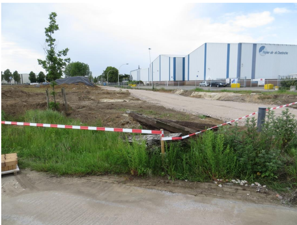
foto 8: IMG_4376.JPG: De bouwweg aan de oostzijde (zijde Stationsstraat) is aangelegd ter plaatse van de in 2011 al gesaneerde K&L-sleuf.
