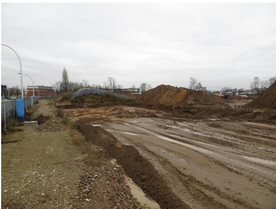
foto 16: IMG_6866.JPG: Voorgrond: herschikken uitgezeefde grond in uitvoering ter hoogte van in mei 2014 gerealiseerde bouwweg langs de Stationsstraat. Het op de achtergrond zichtbare met folie afgedekte depot grond is bij eerdere ontgravingen op het terrein vrijgekomen en later in dit werk ook uitgezeefd/herschikt.
