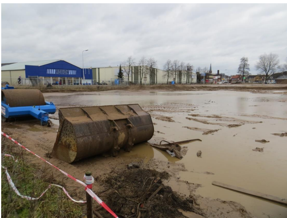
foto 28: IMG_7077.JPG: Overzichtsfoto's medio januari 2015, zeefwerk nadert zijn einde. Uitgezeefde grond grotendeels herschikt.
