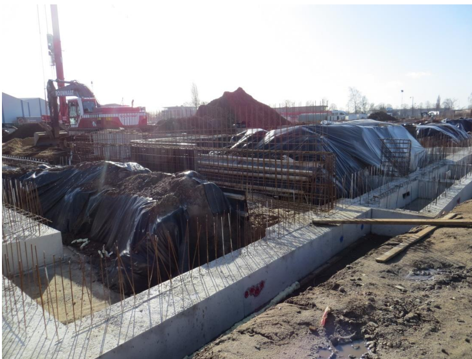
foto 16: IMG_7678.JPG: Aanleg fundaties in uitvoering. De binnen de funderingen opgeslagen, ter plaatse te beschikken verontreinigde grond is afgedekt met folie en de onderliggende verontreinigde grond met een werkvloertje zodat bouwvakkers niet met verontreinigde grond in aanraking komen.
