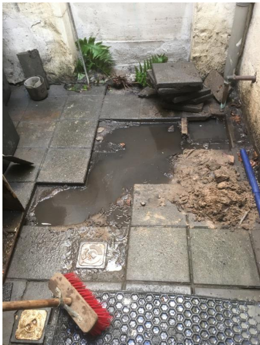
verstopt afvoerputje agv lek in regenafvoer onder residuopslag
