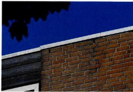
Afbeelding 4.9 Open stootvoegen die toegang bieden tot de spouw. Op deze locatie zit een kolonie van 132 gewone dwergvleermuizen.
