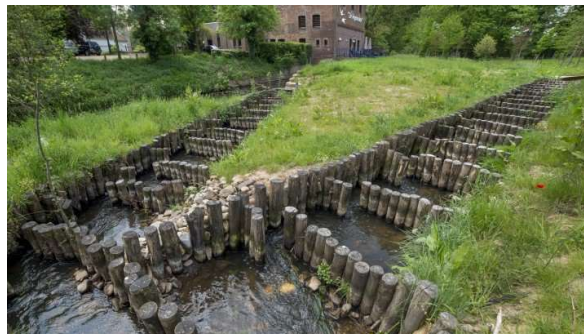
Figuur 12: Vertical slot - links: schematische weergave (bron: Coenen et al, 2013) / Rechts: voorbeeld Vogelmolen (bron: Ger Peeters).
