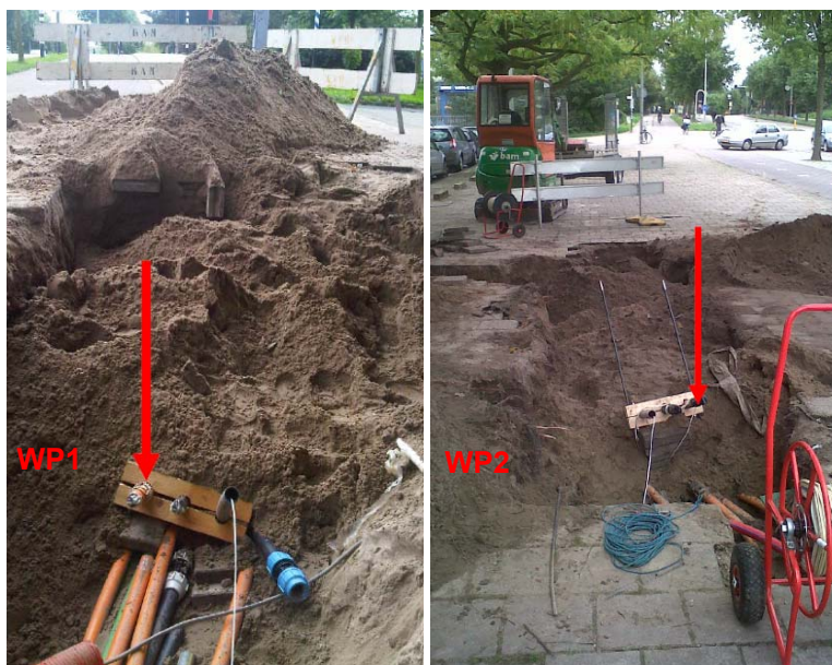
Figuur 2-12: Figuren uit rapport "opmeting" HDD, Reduct, d.d. 30-8-2011, met: ligging, diepte, in- en uittredepunt HDD, en 1016-0640-006_33.R02v4_VO-bemalingsrapport
