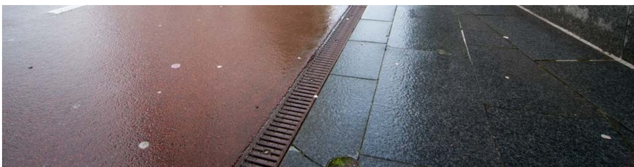
Figuur 15 Bedekte goot Weesperzijde ©Merlijn Michon.
