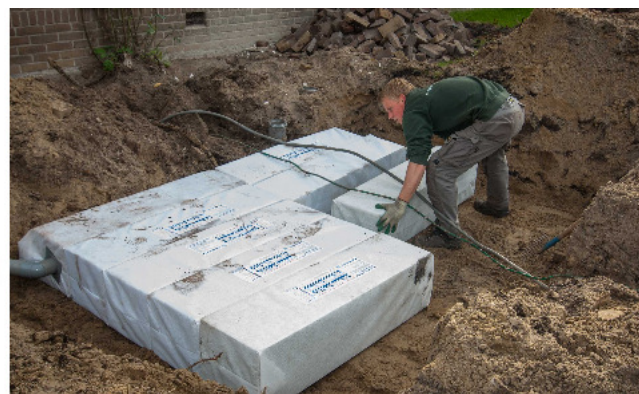
Figuur 9 Voorbeeld van infiltratiekratten. Links: Infiltratiekratten vóór installatie 4 . Rechts: Infiltratiekratten tijdens aanleg 5 .
