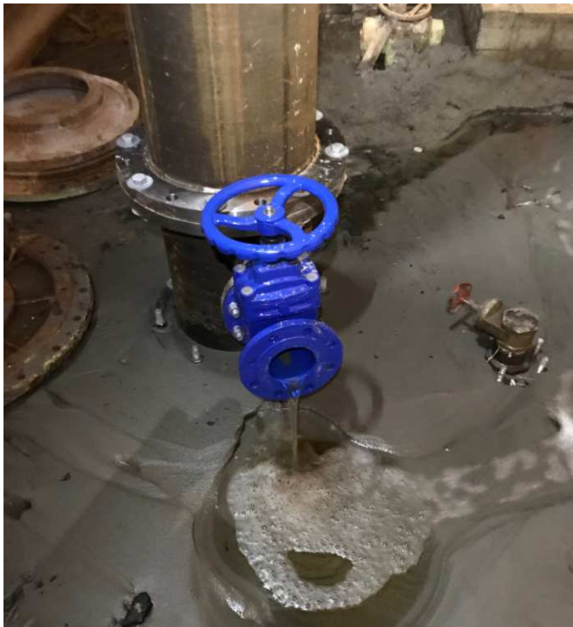
Figuur 4-1 Klein en groot gat met afsluiters
