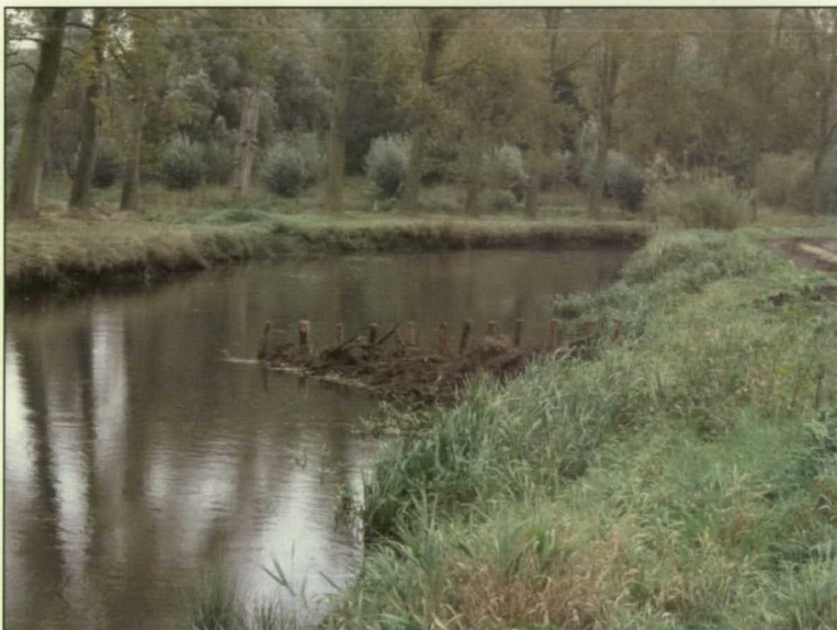
Figuur 2: voorbeeld van een strekdam in de Dommel bij Eindhoven (aangelegd januari 2014).
